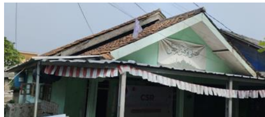
Gambar 2. Kondisi mushola sebelum renovasi
