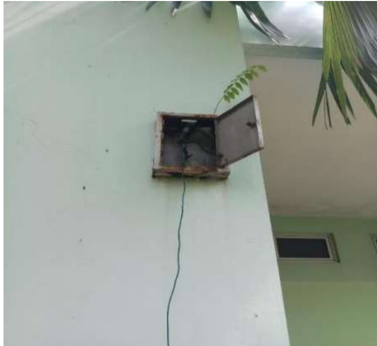
Gambar Bak Kontrol Pada Gedung B
