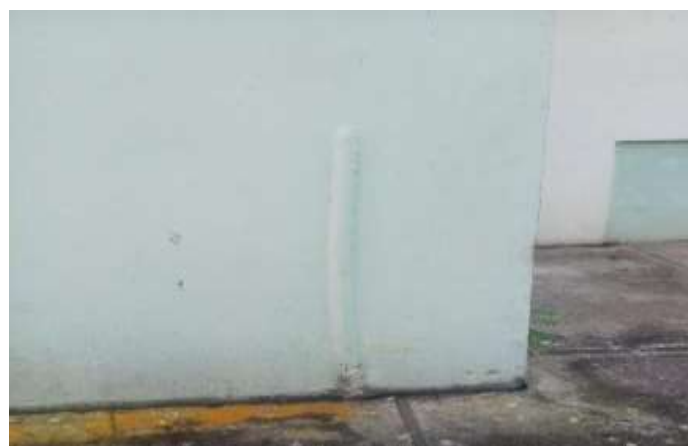
Gambar konduktor penyalur kebawah Gedung B
