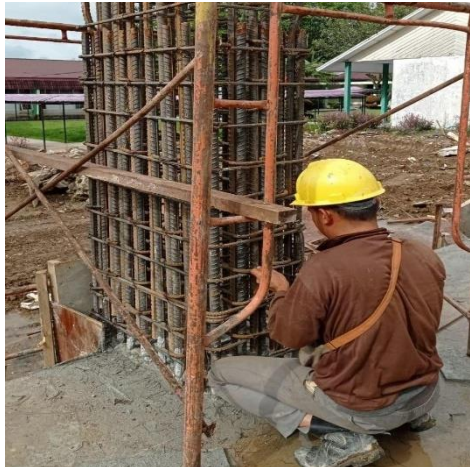
Gambar 1. Para pekerja telah mengenakan helm pelindung sebagai bagian dari penerapan Keselamatan dan Kesehatan Kerja (K3) di lokasi konstruksi.
