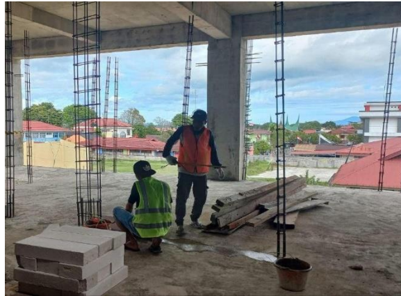
Gambar 2. Pekerja yang telah mematuhi prosedur K3 dengan mengenakan rompi keselamatan yang sesuai.
