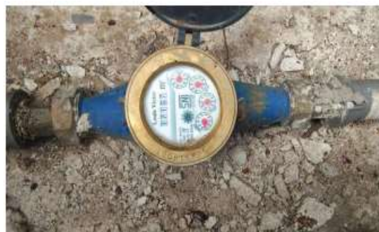
Gambar 5.14 Pemasangan Meteran air (Sumber : Dokumentasi Peneliti 2022)
