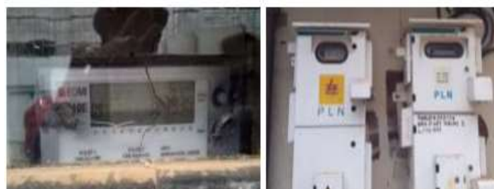
Gambar 5.4 Pemasangan kWh Meter
