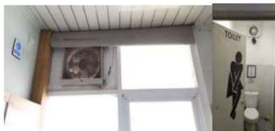
Gambar 5.12 Contoh ventilasi terpasang (Sumber : Dokumentasi Peneliti 2022)
