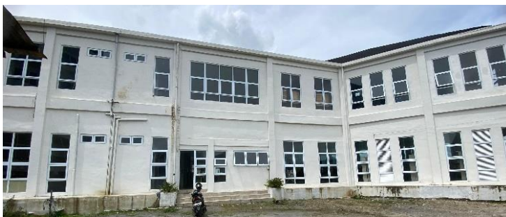
Gambar 9. Tampak belakang bangunan
