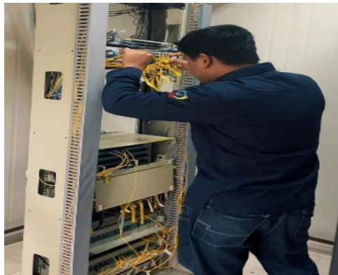
Gambar 1.9 Pemeriksaan kabel fiber optik dan perangkat distribusi jaringan.
